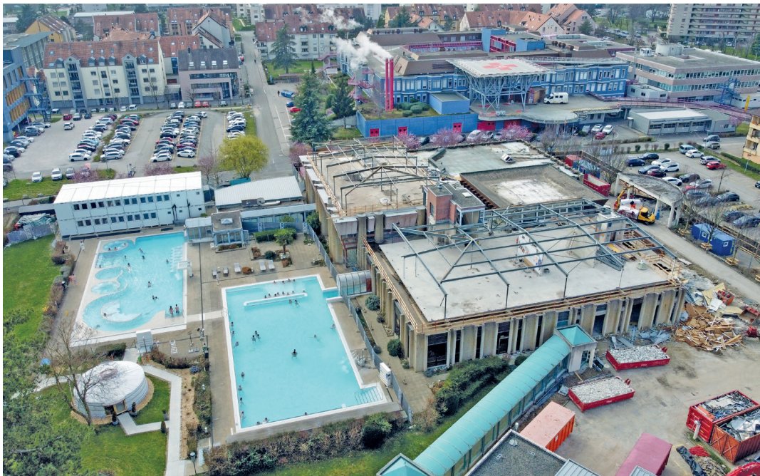
Vue des bassins encore accessibles avec les bâtiments adjacents en cours de démolition en mars 2024. DUPERREX-A
