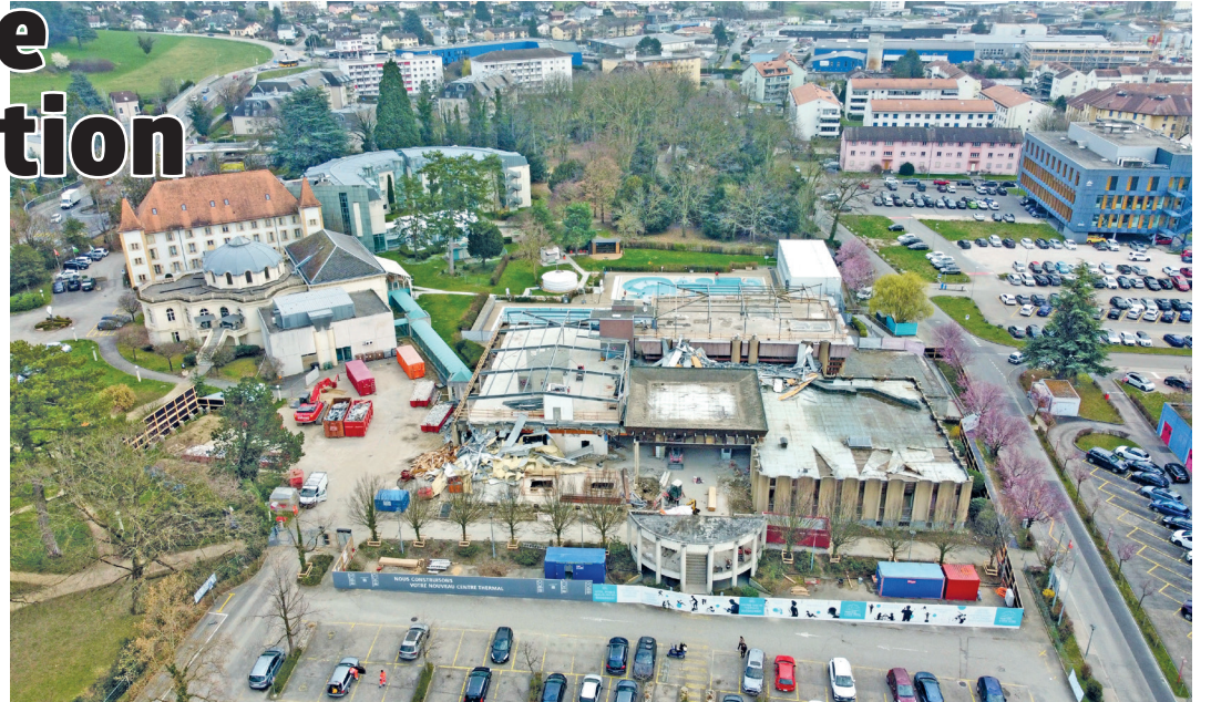
Le site en cours de démolition en mars 2024. DUPERREX-A
