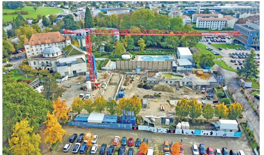
Le site, actuellement, en cours de travaux.
